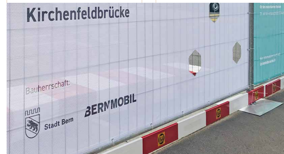
Sicher auch ohne scharfes Auge – hindernisfreier Sockel des Bauzauns mit Fussleiste als Tasthilfe für Sehbehinderte.
