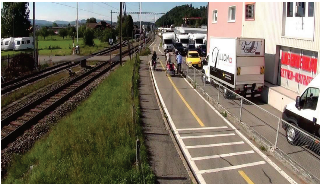
Abb. 41 Querstreifen auf freier Strecke auf der Zufahrt zu einem Knoten auf der Anlage Heimberg – Thun (CH). Hinweis: Die Ausführung (insbes. Farbton) entspricht nicht der VSS-Norm SN 640 214 [64], da die Anlage vor deren Erscheinen erstellt wurde.
