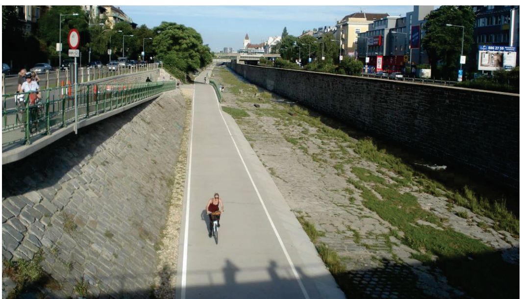
Abb. 25 Gemeinsamer Rad- und Fussweg (4.0 m breit plus „Schutzstreifen“) im städtischen Raum auf der „Radlangstreckenverbindung – Korridor West“, Wien (AT)
