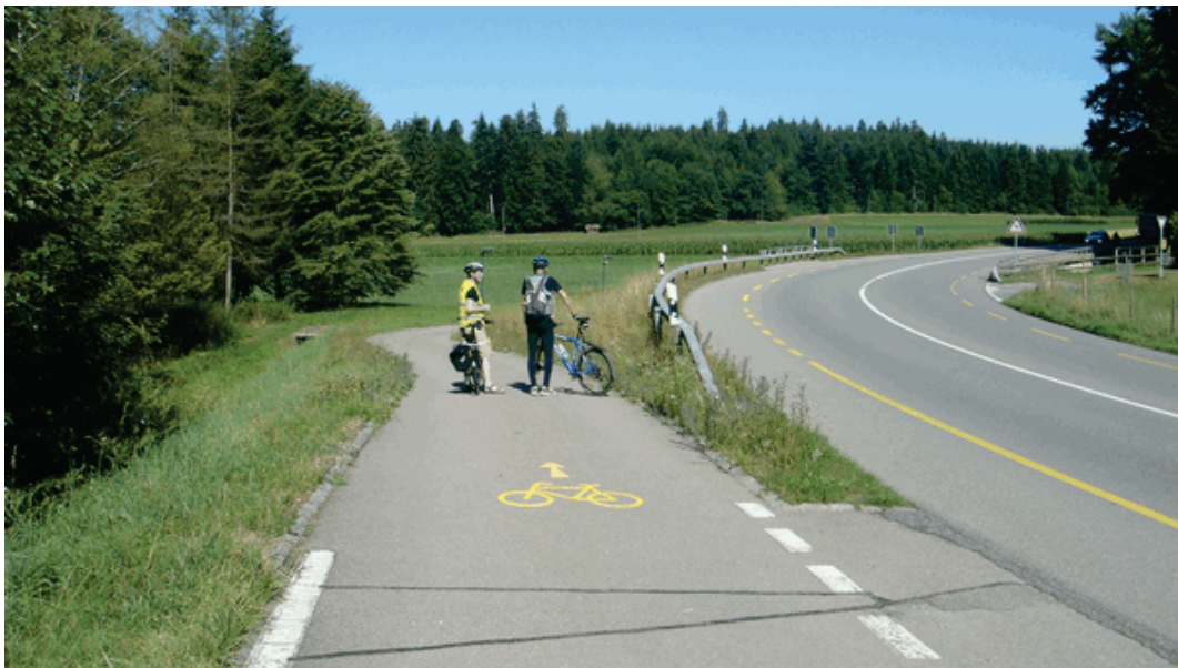
Abb. 58 Gezielter Einsatz eines eindeutigen, gut lesbaren Piktogramms auf der Anlage Thun-Heimberg (CH)
