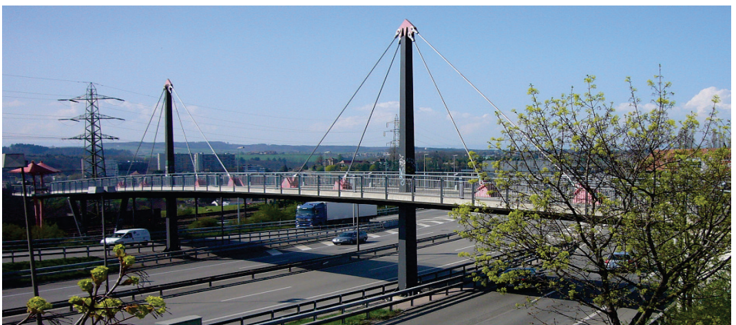
Abb. 40 Velobrücke in Ittigen bei Bern (CH); Foto: Christof Bähler
