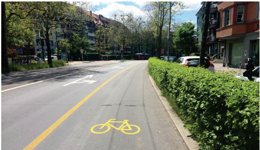
Abb. 21 Breiter Radstreifen (2.50 m breit) mit durchgezogener Linie auf der „Velohauptroute Wankdorf“ im städtischen Raum, Bern (CH)
