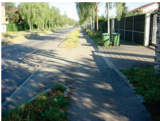
Abb. 120: A2, Doppelangebot: Radstreifen und Richtungsradweg, Fahrtrichtung Bern
