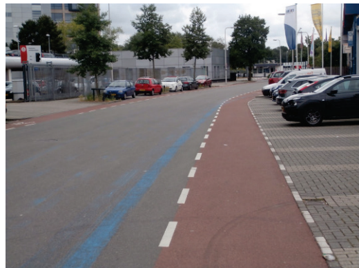
Abb. 29 Veloroute klar getrennt von parkierenden Autos
