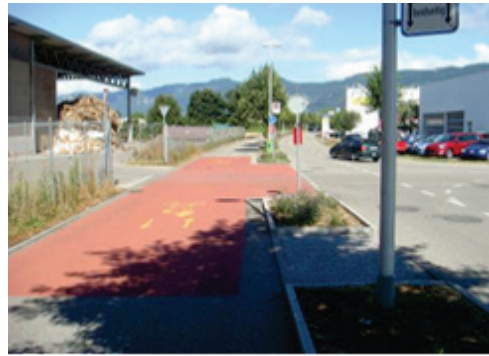
Abb. 21 Einfahrt zu Industriebetrieb: Veloschnellroute durchgezogen ergibt eine klare Vortrittsregelung
