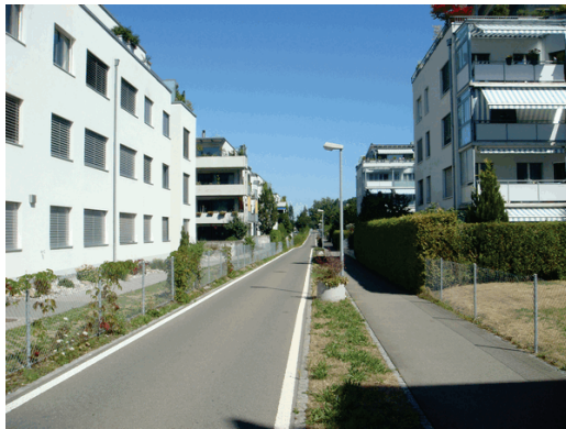
Abb. 37: A1, Zweirichtungsradweg mit abgetrenntem Fussweg
