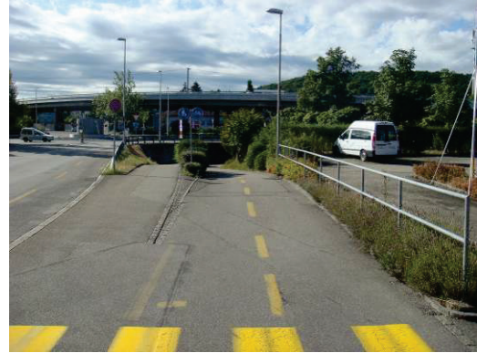
Abb. 81: K2, Zufahrt Unterführung auf Rad- und Fussweg mit getrennten Verkehrsflächen, Zuchwil
