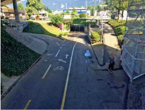
Abb. 80: K2, Unterführung auf Rad- und Fussweg mit getrennten Verkehrsflächen, Zuchwil
