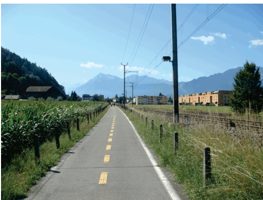
Abb. 45: Zweirichtungsradweg Heimberg höhe Grabehüsibach*
