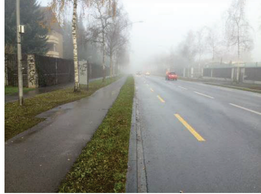
Abb. 123: A2, Doppelangebot: Radstreifen, und Richtungsradweg, Fahrtrichtung Kehrsatz
