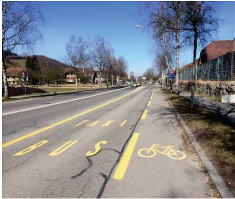
Abb. 214: Busstreifen mit Radstreifen, Wabern-Kehrsatz A1
